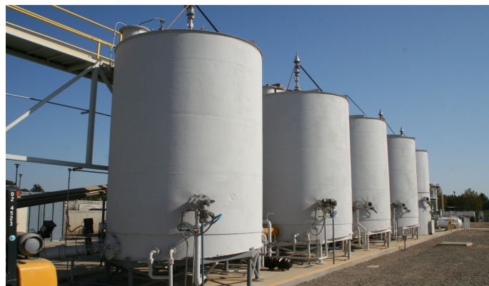
Tanque de digestão aeróbia (esquerda) pode ser aberto por não emitir mau cheiro, já o de digestão anaeróbia (direita) normalmente é fechado para evitar a emissão direta de odores ao ambiente.
